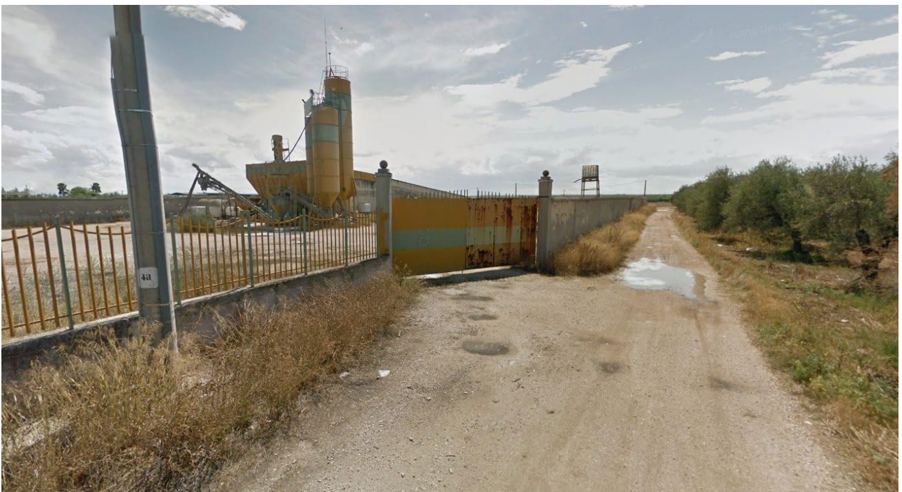
Figura 58 Particolare ingresso (Settembre 2012)
